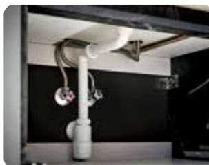
升級隱藏式排水管
