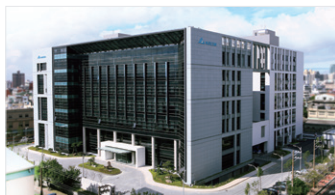
台北瑞光大樓2 LEED 白金級 EEWH 鑽石級 WELL健康-安全評價
